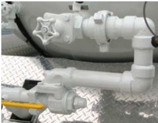
Les soupapes de dérivation différentielle Blackmer sont conçues pour protéger les pompes et autres éléments du système de dommages résultant d'une pression excessive, et aucune installation de pompage de GPL n'est complète sans une de ces soupapes. Blackmer offre cinq modèles différents qui
