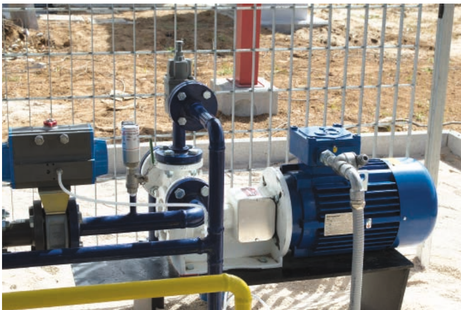
Die regenerativen Turbinenpumpen der Ebsray RC40-Serie sind kleiner als vergleichbare Pumpen, was Stromkosten spart. Trotz des kleineren Motors kann die Pumpe zuverlässig und wirtschaftlich Differenzdrücke bis zu 14 bar mit Durchflussraten von bis zu 200 l/min erzeugen.
