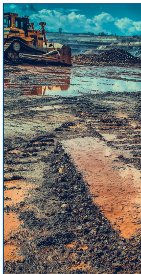
REMOÇÃO DE ÁGUA
